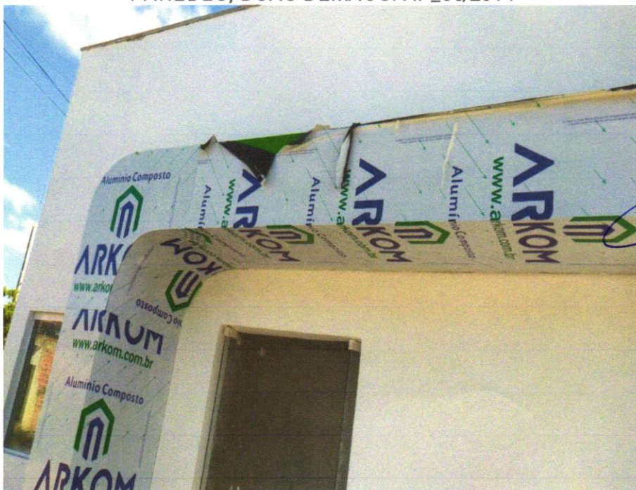
FOTO 46 - Revestimento metálico em alumínio composto (Alucobond), e=0,3mm, pintura Kaynar 500 composta por seis camadas, inclusive estrutura metálica auxiliar em perfil de viga "U" de 2" - fornecimento e montagem
