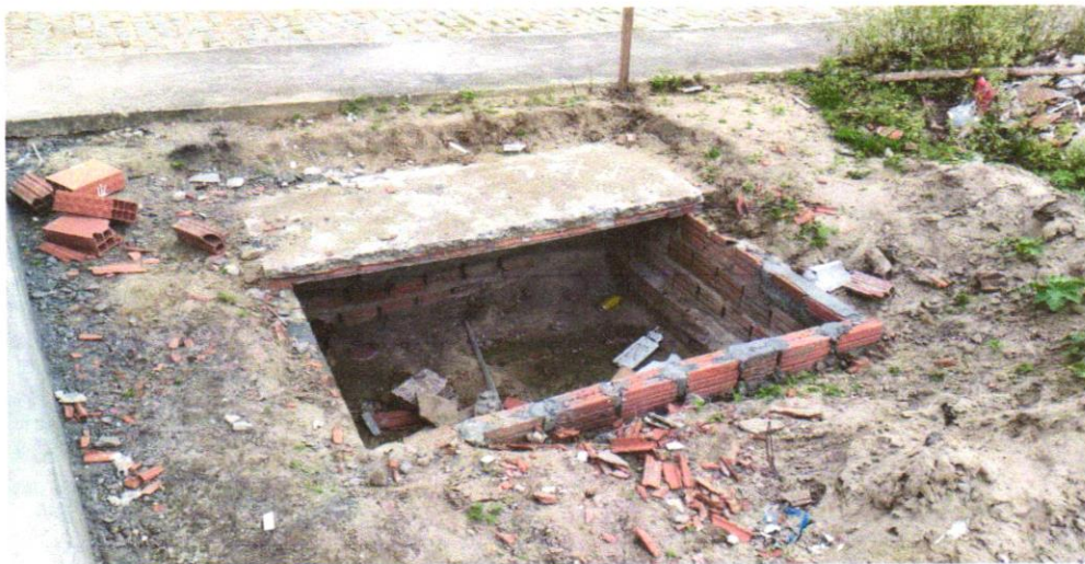
FOTO 10 Fossa séptica pré-moldada, tipo oms, capacidade 15 pessoas (v=900 litros)
