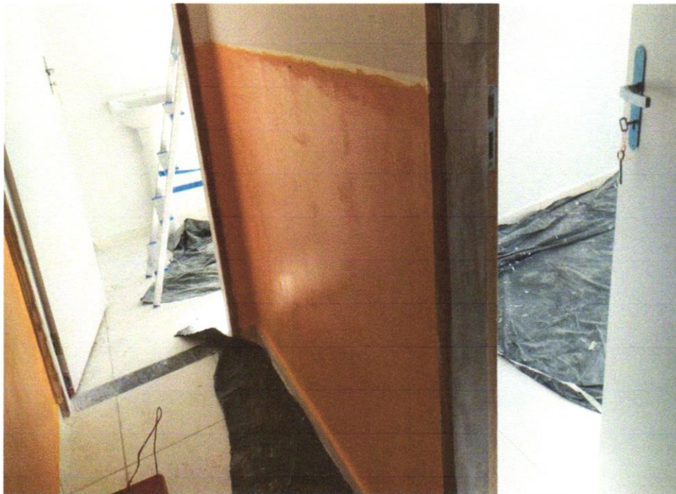
Foto 45 – APLICAÇÃO MANUAL DE PINTURA COM TINTA LÁTEX ACRÍLICA EM PAREDES, DUAS DEMÃOS. AF_06/2014
