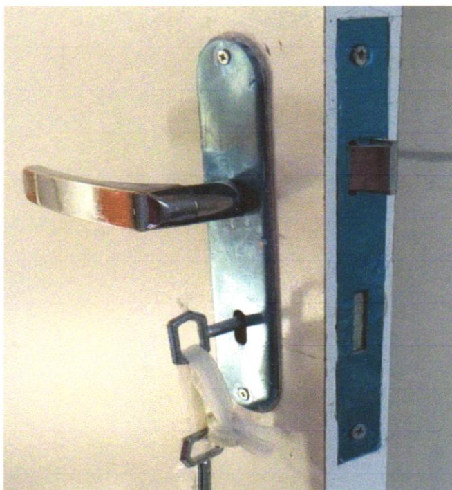
Foto 41 - FECHADURA DE EMBUTIR PARA PORTA DE BANHEIRO, COMPLETA, ACABAMENTO PADRÃO MÉDIO, INCLUSO EXECUÇÃO DE FURO - FORNECIMENTO E INSTALAÇÃO. AF_12/2019
