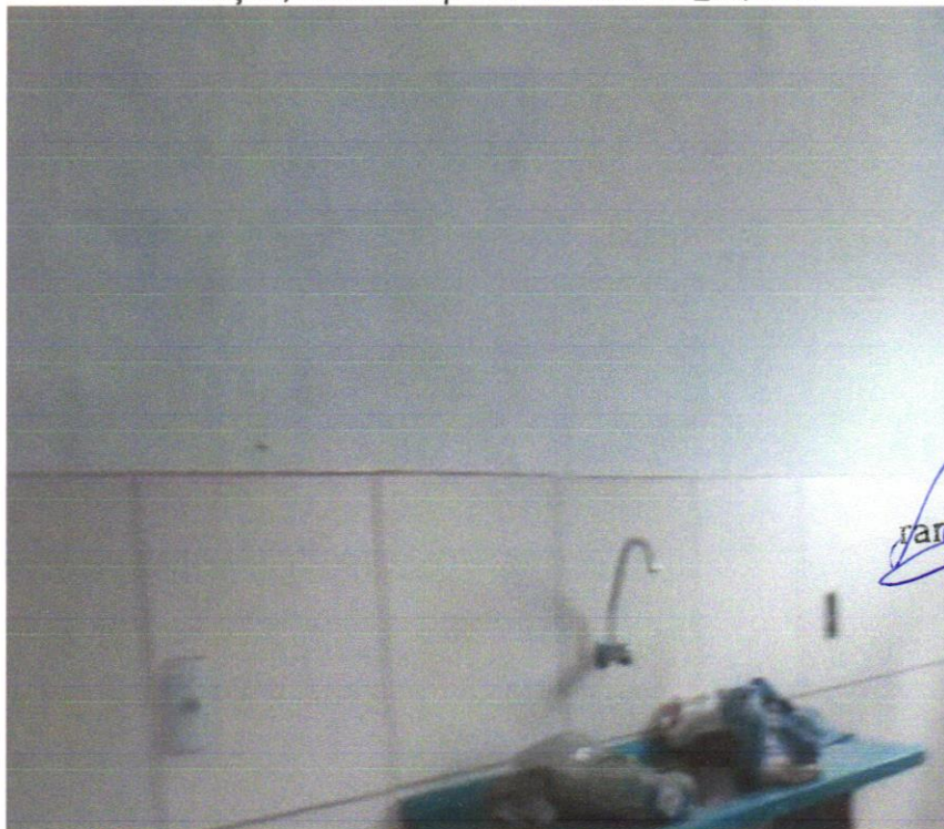
FOTO 32 - Pia de cozinha com bancada em aço inox, dim 1,20x0,60m c/ 01 cuba, válvula cromada, sifão cromado e torneira cromada, concretada e assentada. Rev.04
