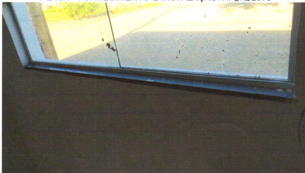
Foto 36 – PEITORIL LINEAR EM GRANITO OU MÁRMORE, L = 15CM, COMPRIMENTO DE ATÉ 2M, ASSENTADO COM ARGAMASSA 1:6 COM ADITIVO. AF_11/2020
