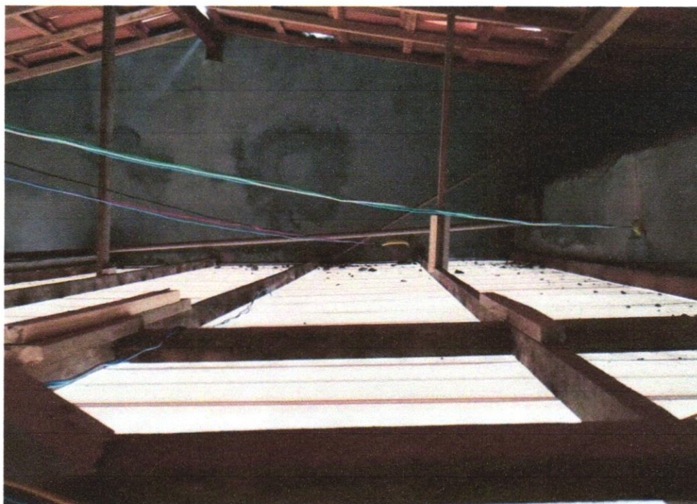
FOTO 25 - TUBO, PVC, SOLDÁVEL, DN 25MM, INSTALADO EM RAMAL OU SUB-RAMAL DE ÁGUA - FORNECIMENTO E INSTALAÇÃO. AF_06/2022
