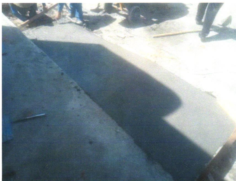
FOTO 14 –EXECUÇÃO DE PASSEIO (CALÇADA) OU PISO DE CONCRETO COM CONCRETO MOLDADO IN LOCO, FEITO EM OBRA, ACABAMENTO CONVENCIONAL, ESPESSURA 8 CM, ARMADO. AF_07/2016
