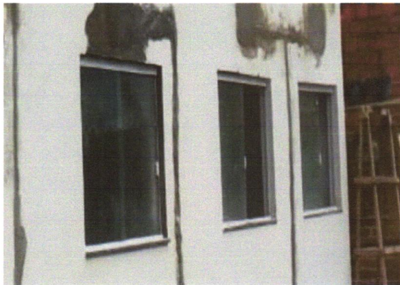
Foto 37-JANELA DE ALUMÍNIO DE CORRER COM 2 FOLHAS PARA VIDROS, COM VIDROS, BATENTE, ACABAMENTO COM ACETATO OU BRILHANTE E FERRAGENS. EXCLUSIVE ALIZAR E CONTRAMARCO. FORNECIMENTO E INSTALAÇÃO. AF_12/2019
