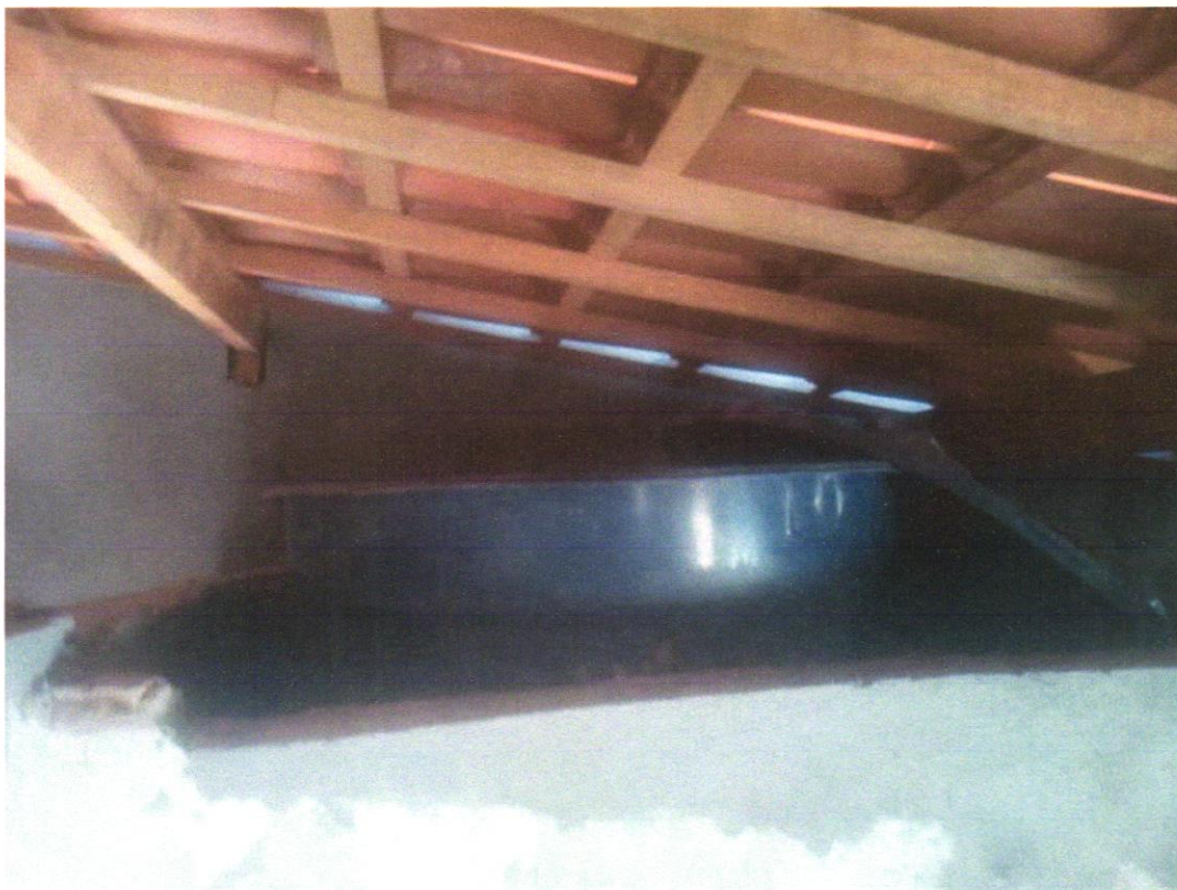
FOTO 19 – CAIXA D'ÁGUA EM POLIÉSTER REFORÇADO COM FIBRA DE VIDRO, 500 LITROS - FORNECIMENTO E INSTALAÇÃO. AF_06/2021
