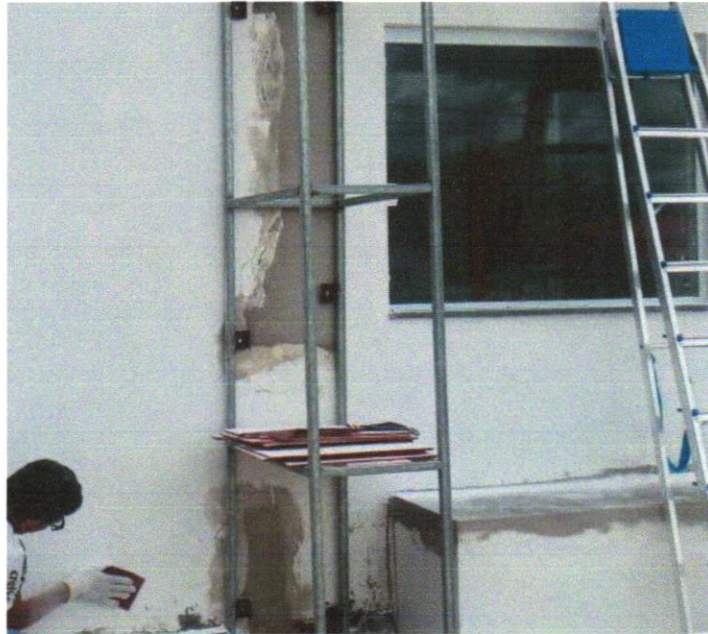
Foto 29 - APLICAÇÃO E LIXAMENTO DE MASSA LÁTEX EM PAREDES, UMA DEMÃO. AF_06/2014
