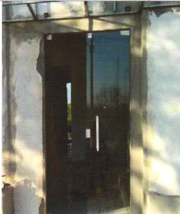
FOTO 31 - Porta em vidro temperado 10mm, incolor, inclusive ferragens de fixação e instalação, exclusive puxador - Rev 01_10/2021
