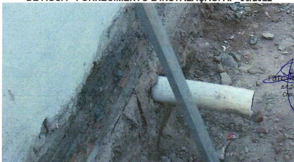
FOTO 26 - TUBO DE PVC BRANCO PARA REDE COLETORES DE ESGOTO CONDOMINIAL DE PAREDE MACIÇA, DN 100 MM, JUNTA ELÁSTICA - FORNECIMENTO E ASSENTAMENTO. AF_01/2021
