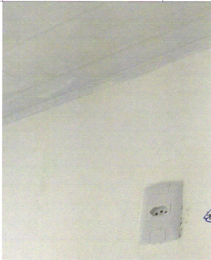
Foto 35 – TOMADA ALTA DE EMBUTIR (1 MÓDULO), 2P+T 10 A, INCLUINDO SUPORTE E PLACA - FORNECIMENTO E INSTALAÇÃO. AF_12/2015
