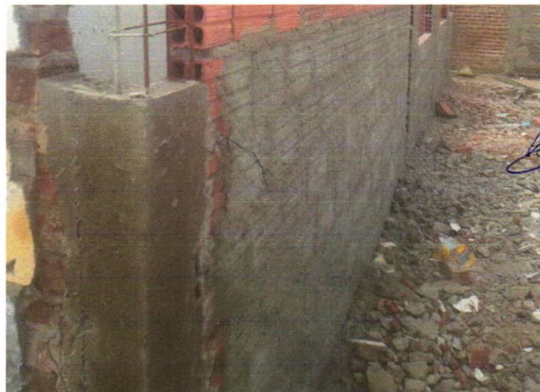
Foto 38 -COMPOSIÇÃO REPRESENTATIVA) EXECUÇÃO DE ESTRUTURAS DE CONCRETO ARMADO, PARA EDIFICAÇÃO HABITACIONAL UNIFAMILIAR TÉRREA (CASA EM EMPREENHIMENTOS), FCK = 25 MPA. AF_01/2017
