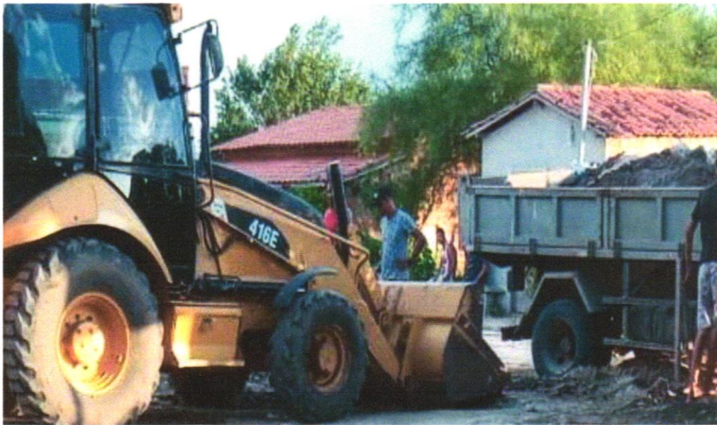
FOTO 27 - transporte com caminhão basculante
