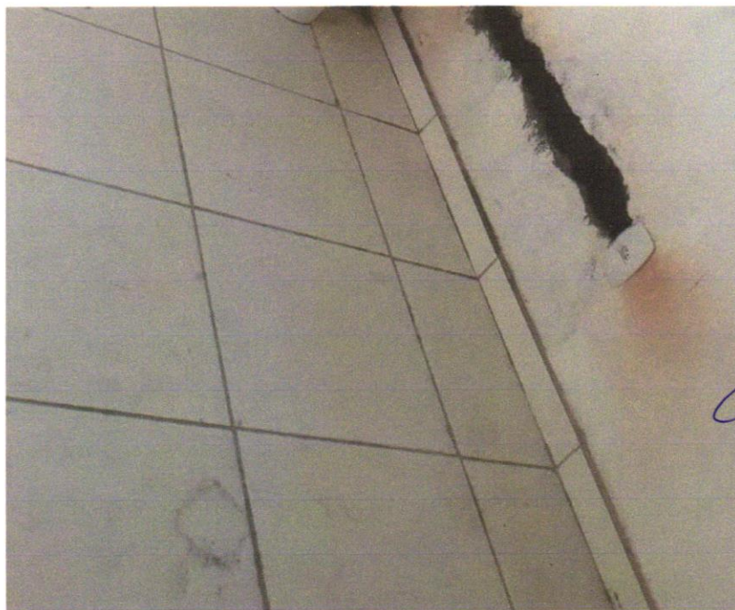
FOTO 11 - RODAPÉ CERÂMICO DE 7CM DE ALTURA COM PLACAS TIPO ESMALTADA EXTRA DE DIMENSÕES 45X45CM. AF_06/2014
